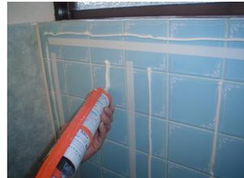
■掻き落とし壁へのボンド、テープ充填
